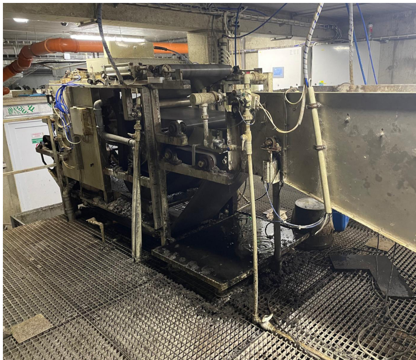
Obr. 6. Pásový filtr pro odvodnění flokulovaného kalu (Foto R. Gebauer).
