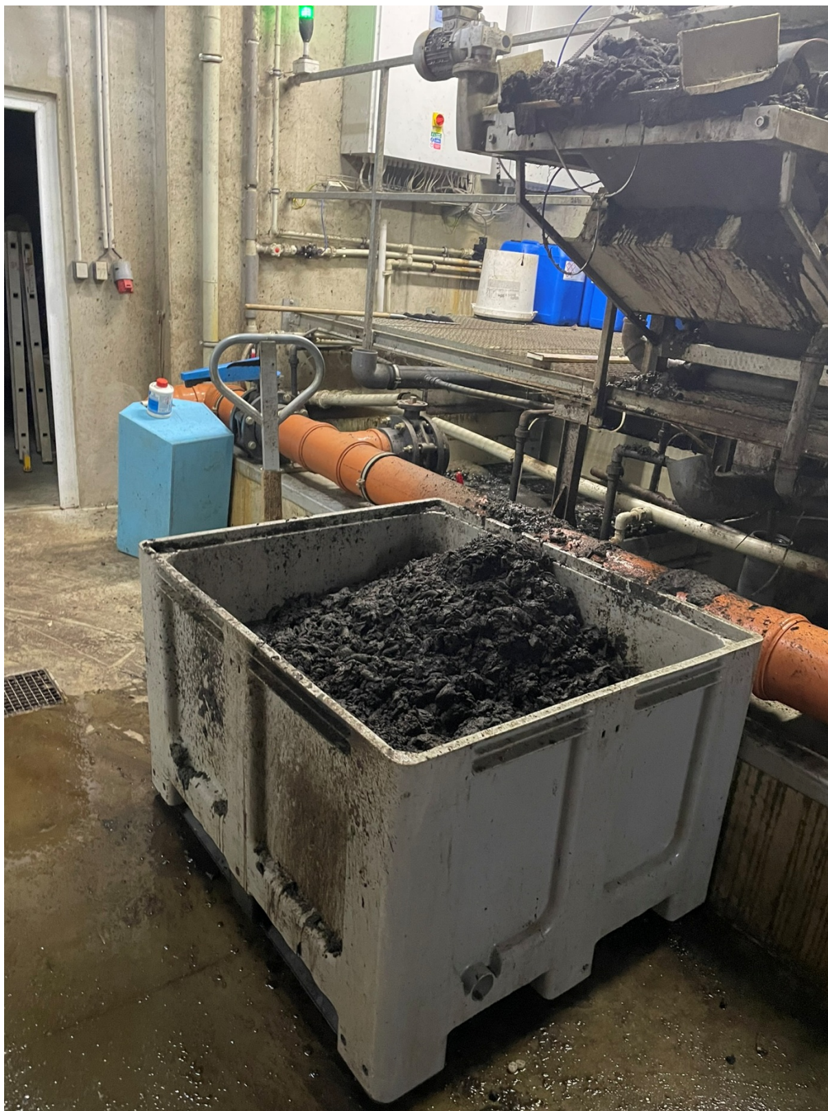
Obr. 7. Sběrná nádoba odvodněného flokulovaného kalu (foto R. Gebauer).
