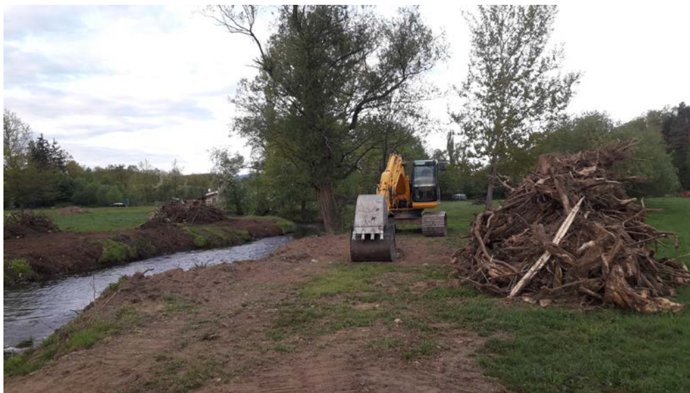
Obr. 2. Odstraňování kořenových systémů z břehové linie zásadně snižuje úkrytovou kapacitu toku pro ryby (Foto: T. Randák).
