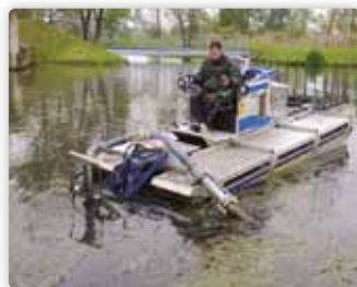
Odsávání bahenního sedimentu – přečerpávací stanice Šakvice.
