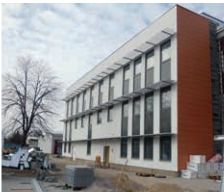
Výstavba nové budovy FROV JU a ZF JU v ulici Na Sádkách v Českých Budějovicích, jež bude sloužit pro výuku a VaV činnost.
