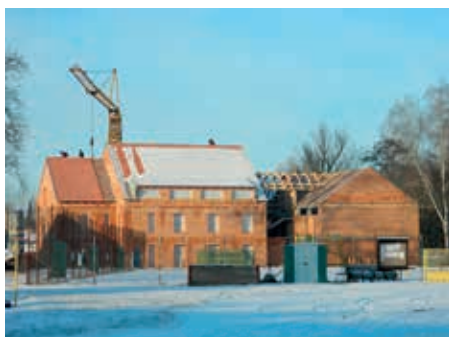
Budova Mezinárodního environmentálního vzdělávacího, poradenského a informačního střediska ochrany vod Vodňany (MEVPIS) před a během rekonstrukce.
