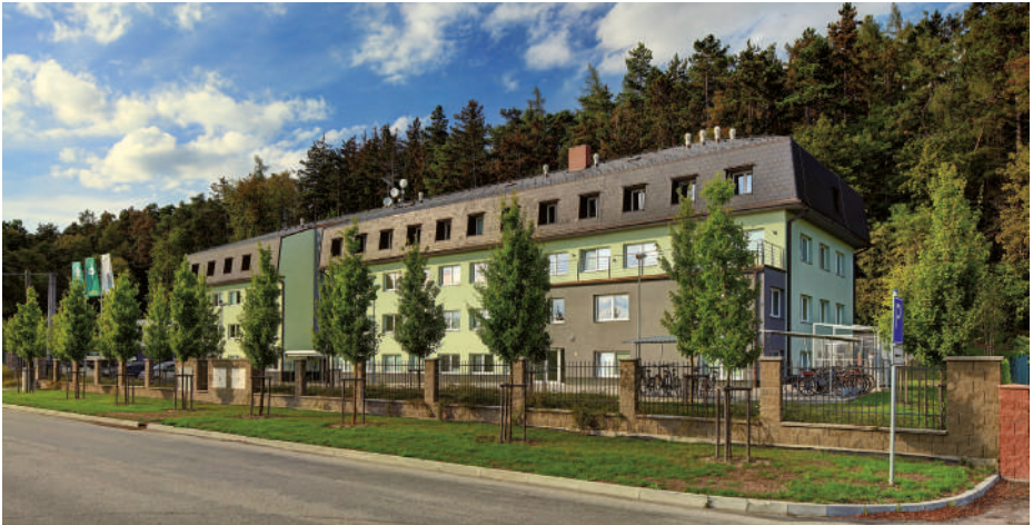
Rekonstruovaná hlavní budova FROV JU ve Vodňanech.
