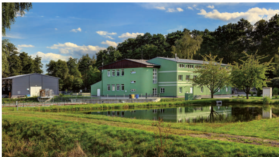
Rekonstruovaný objekt Experimentálního rybochovného pracoviště a pokusnictví VÚRH ve Vodňanech.
