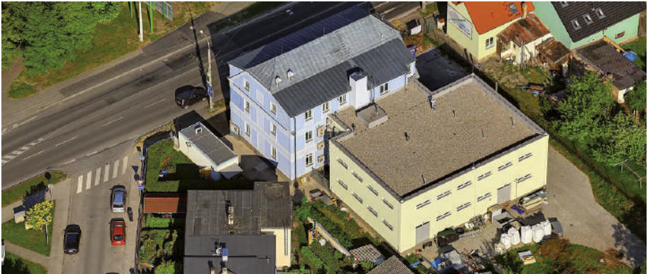
Letecký snímek budovy Ústavu akvakultury a ochrany vod v Husově ulici v Českých Budějovicích.
