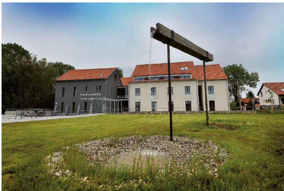
Budova střediska MEVPIS FROV JU Vodňany.
