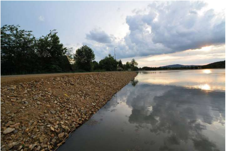
Opravená hráz rybníku Velká Okrouhlice.
