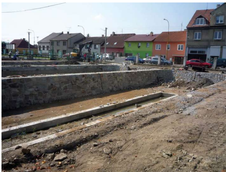
Opravené rybí sádky v ulici Tyršova ve Vodňanech.
