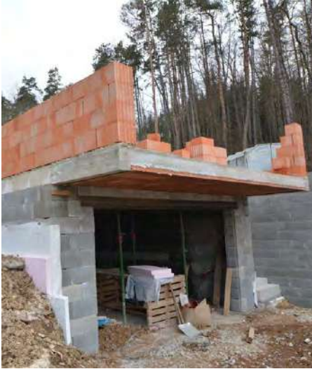
Aktuální foto stavby.
