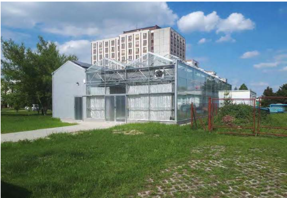
Nově vybudovaná výzkumná akvaponická hala v univerzitním kampusu.
