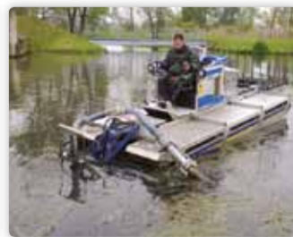
Odsávání bahenního sedimentu – přečerpávací stanice Šakvice.
