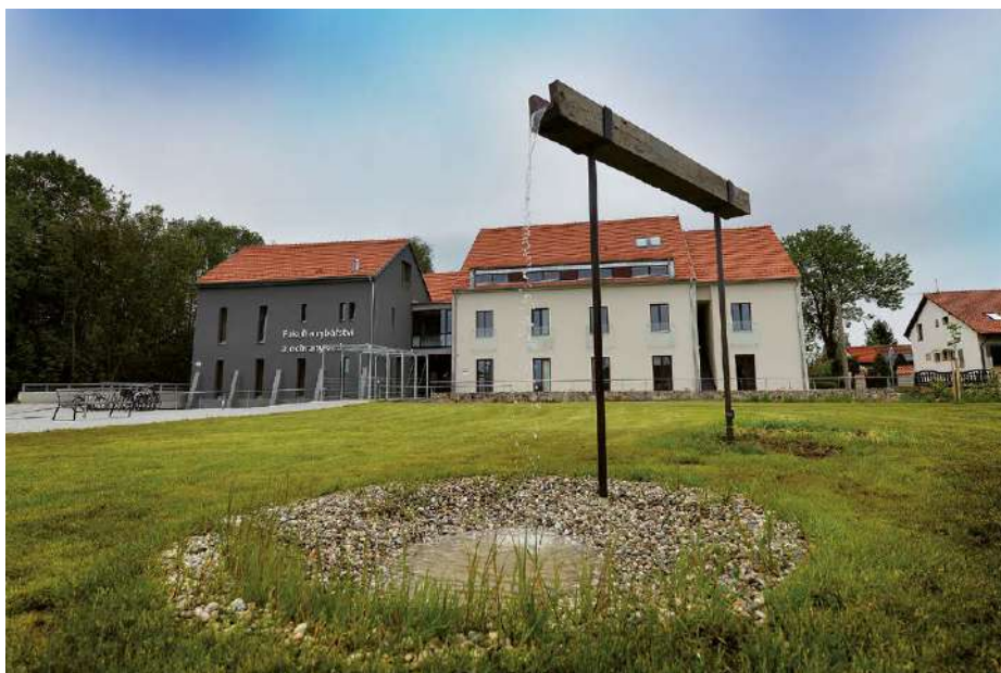
Budova střediska MEVPIS FROV JU Vodňany.
