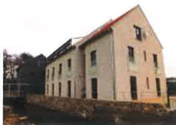
Obr. č. 6 - Rekonstruovaný mlýn (objekt MEVPIS)
