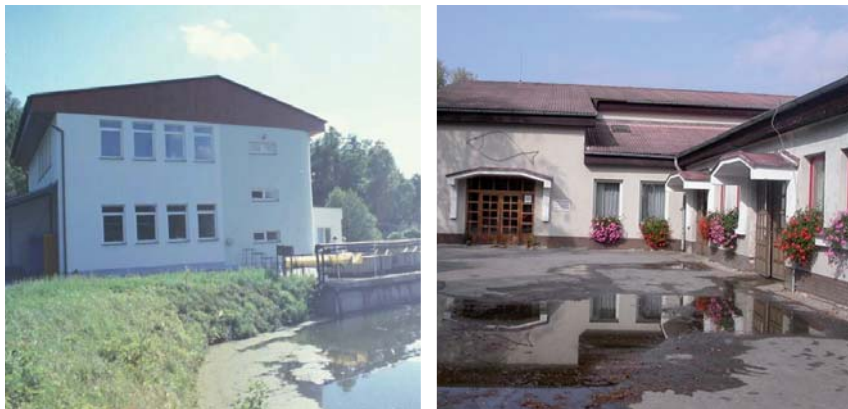
Obr. 1. a 2. Experimentální hala a venkovní žlabovna VÚRH JU ve Vodňanech a Rybí líheň Rybníkářství Hluboká s.r.o. (exteriér).
