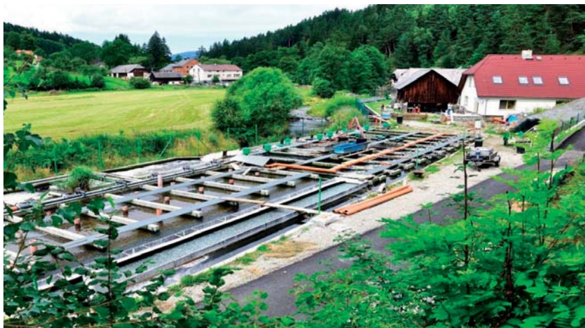
Obr. 1. Celkový pohled na recirkulační systém dánského typu.
