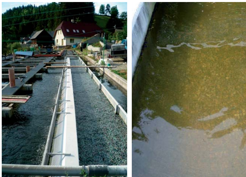
Obr. 13. Pohled na plovoucí biofiltr rozpohybovaný pomocí vzduchu (vlevo) a pohled na elementy ponořeného biofiltru (vpravo).
