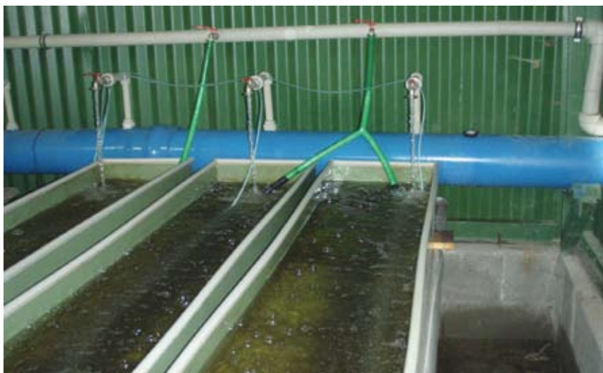
Obr. 6. Mělké žlaby s přidáním vzduchování používané k počátečnímu odchovu plůdku pstruha obecného (Foto: T. Randák).
