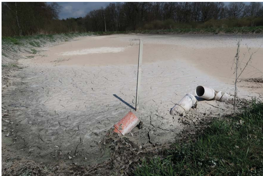
Obr. 1.2. První ze dvou sedimentačních lagun na rybníku Rožmberk k zachytávání bahna odsávaného z loviště pomocí sacího bagru. Stav laguny v dubnu po povápnění sedimentu těženého v srpnu/září předchozího roku (Foto J. Regenda).
