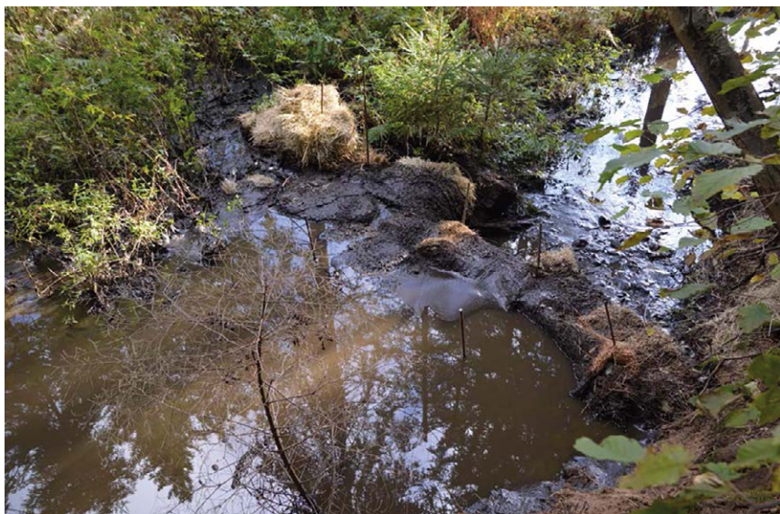
Obr. 4.11. Dočasné bariéry z balíků slámy byly rovněž instalovány na Křišťanovickém rybníku z důvodu prevence nežádoucího úniku sedimentu do řeky Blanice při odbahňování (Foto: J. Regenda).
