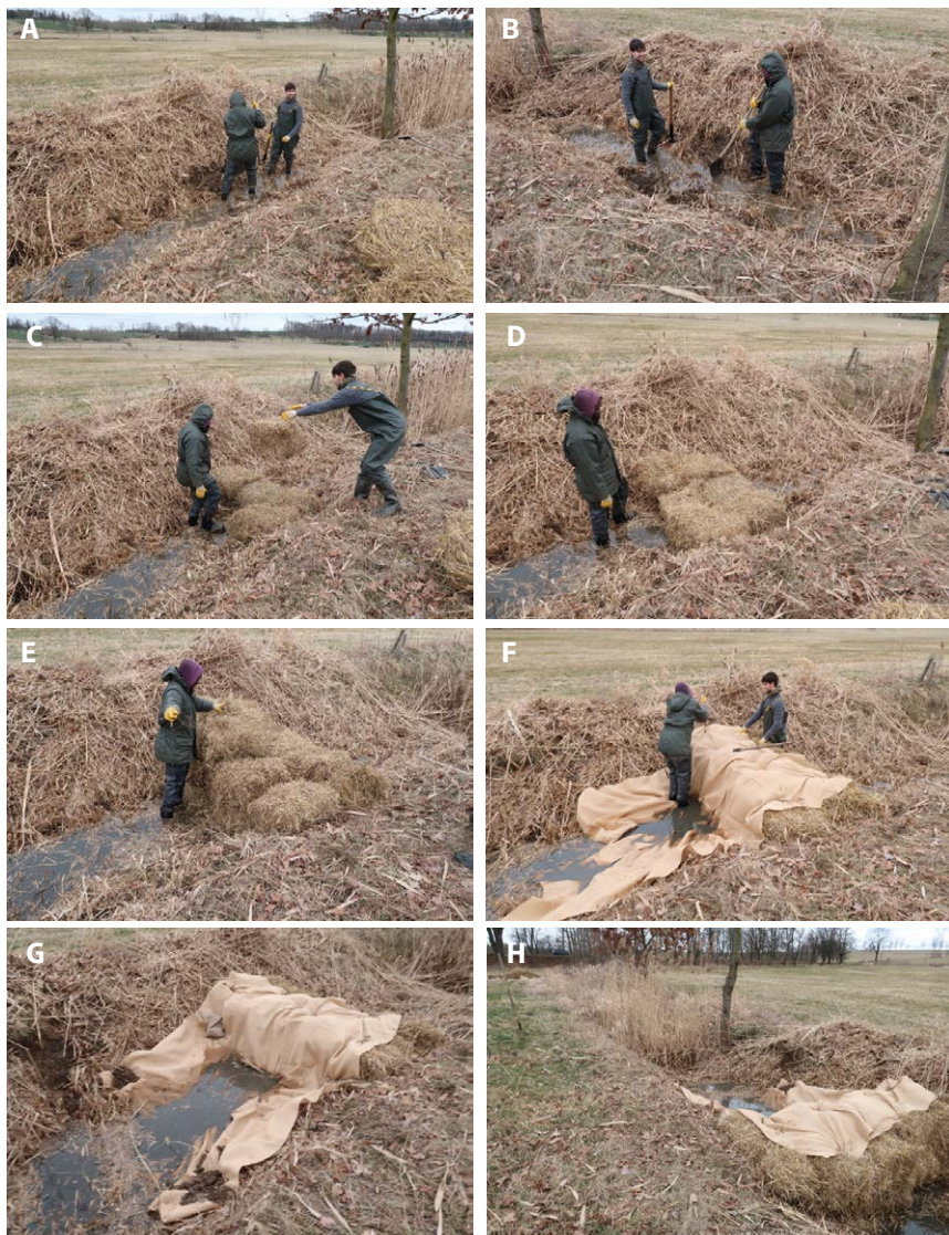
Obr. 4.3. Ukázka postupu výstavby dočasné bariéry z balíků slámy ve stoce pod rybníkem: A – vyčištění profilu stoky, B – terénní úpravy koryta stoky při založení spodní řady, C – zakládání spodní řady balíků, D – dokončení první řady, E – ukládání druhé řady balíků a jejich fixace pomocí trnů, F – instalace jutové tkaniny k omezení podtékání bariéry, G a H – pohled na hotovou bariéru (Foto: J. Regenda).
