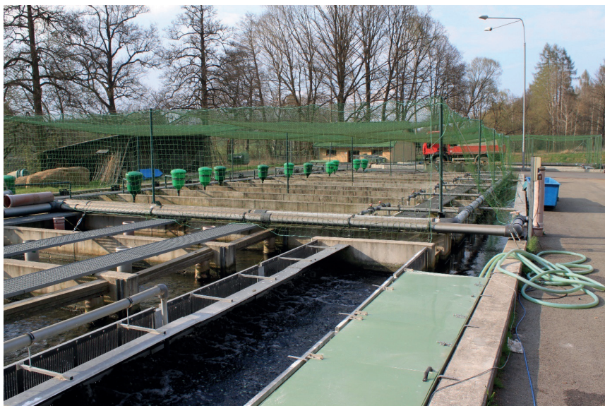
Obr. 16. Venkovní horizontální RAS dánského typu v Pravíkově, BioFish, s.r.o. (Foto: J. Regenda).
