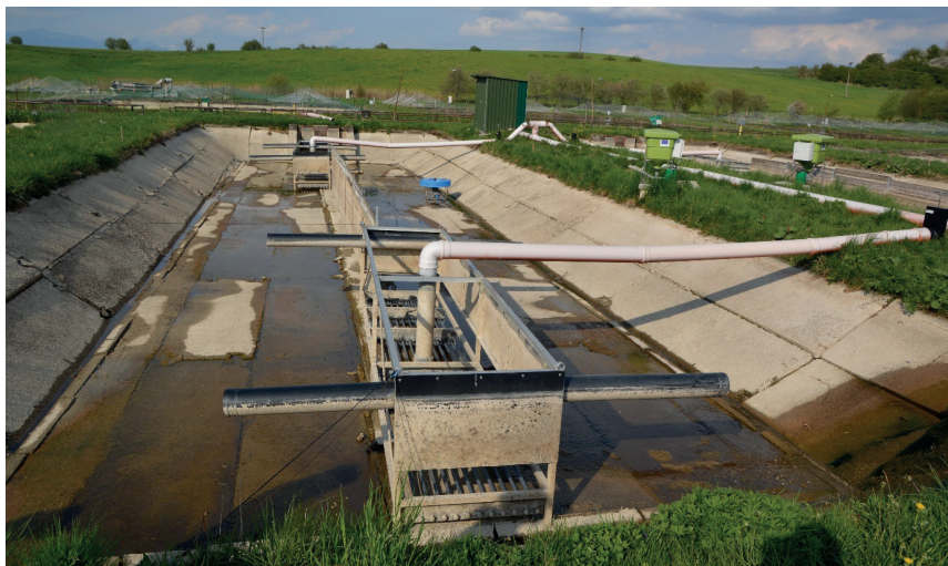
Obr. 21. Historický betonový rybník intenzifikovaný vložím dvojice airliftů a přepážky na farmě Příbovce – Slovryb, a.s., Slovensko (Foto: J. Regenda).
