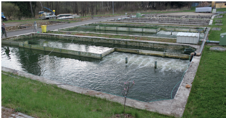
Obr. 22. Betonová sádka využita k efektivnějšímu chovu pstruha duhového pomocí rozpohybování vody airliftem, Pravíkov – BioFish, s.r.o. (Foto: J. Regenda).
