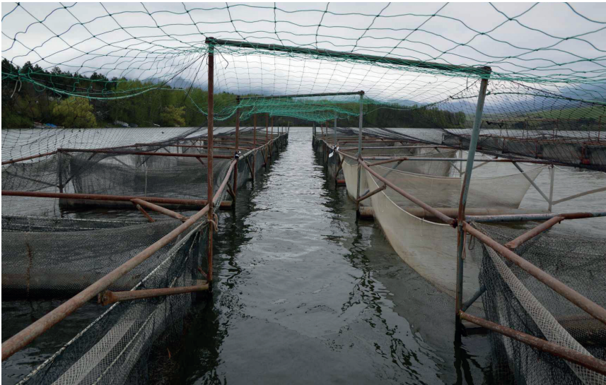
Obr. 2. Konstrukce plovoucích klecí vyvinutá Státním rybářstvím, o.p. v 70. letech 20. st. v Československu, baterie o 10 klecích s rozměrem 4 x 3 x 4 m, Liptovská Mara, objekt SRZ Rada, o.z. (Foto: J. Regenda).
