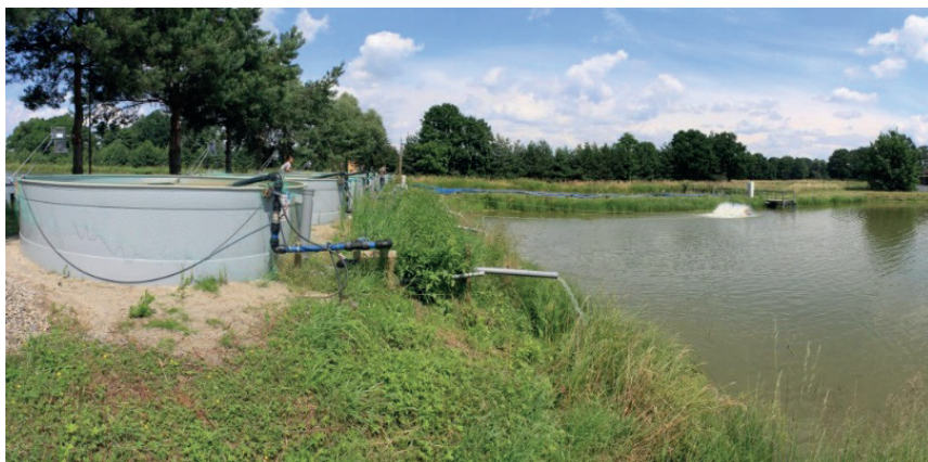
Obr. 27. V některých případech mohou být nádrže s rybami umístěny na břehu s nutností čerpání vody čerpadly. Přilehlý rybník je zdrojem vody a zároveň funguje jako čističí jednotka, IRS Golysz, Polsko (Foto: J. Regenda).
