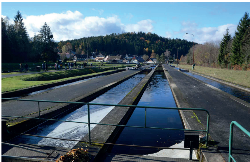
Obr. 8. Pohled na odchovné betonové kanály „italského typu“ rozdělené na tři oddělení na farmě Annín postavené v roce 1970 (Klatovské rybářství, a.s.) (Foto: J. Regenda).
