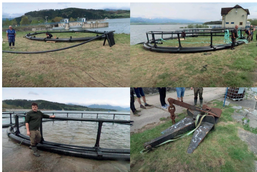
Obr. 4. Montáž nových moderních klecí na chov lososovitých ryb na břehu Liptovskej Mary, včetně jedné ze dvou kotev o hmotnosti 450 kg, Slovrbyb, a.s. (Foto: J. Regenda).
