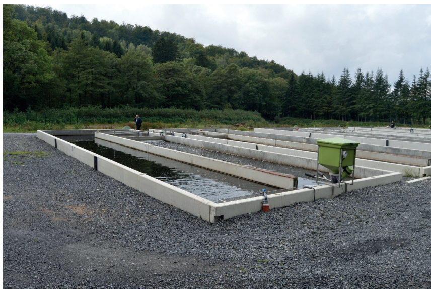
Obr. 19. Semirecirkulační systém s chovem lososovitých ryb a jeseterů na farmě Gresfeld, Fischzucht Rhönforelle, GmbH. & Co. KG, Německo (Foto: J. Regenda).
