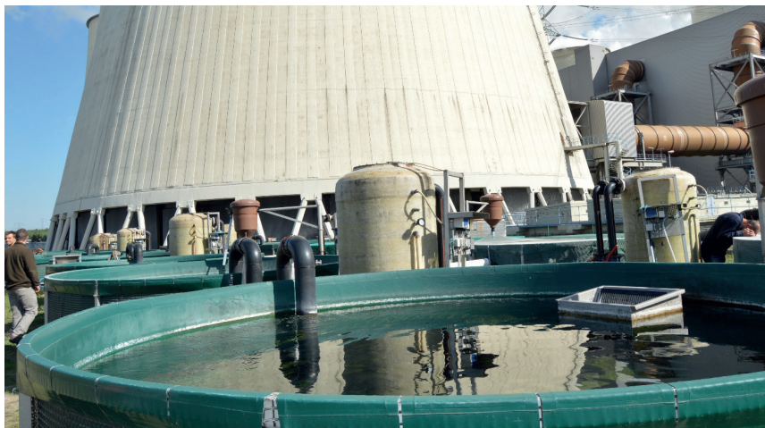
Obr. 12. Odchovné nádrže využívající odpadní oteplenou vodu jsou umístěny přímo v areálu elektrárny Jänschwalde a slouží především k odchovu násady kapra, Teichgut Peitz, GmbH; Německo (Foto: J. Regenda).
