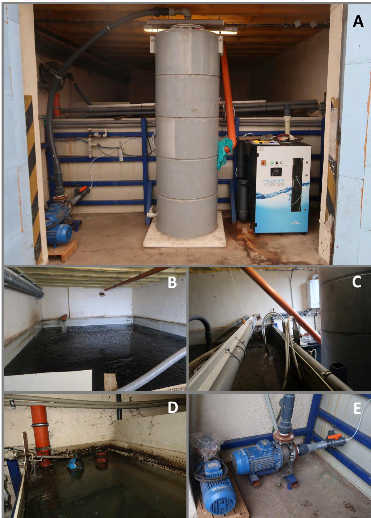
Obr. 3.11 Celkový pohled na prostor biofiltru a úpravy vody (ohřev, oxygenace, ozonizace – A), nádrž biofiltru – B, klidová část biofiltru s výměníkem tepla voda:voda – C, udržování výšky vody v biofiltru plovákem a doplňování ztrát vody z řádu/studny – D, funkční a záložní čerpadlo – E, foto J. Regenda
