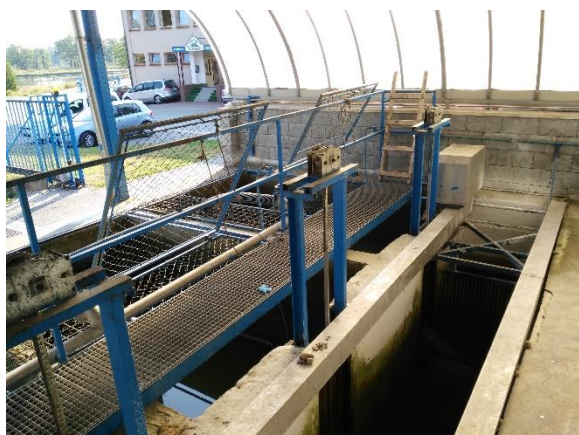
Obr. 3. Vlevo: pohled na výpustní zařízení manipulačních nádrží a slovovací kanál. Vpravo: pohled na vypuštěnou manipulační nádrž a aerační trubici starého systému.
