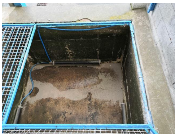
Obr. 4. Pohled na vypuštěnou manipulační nádrž a aerační trubice nového systému.
