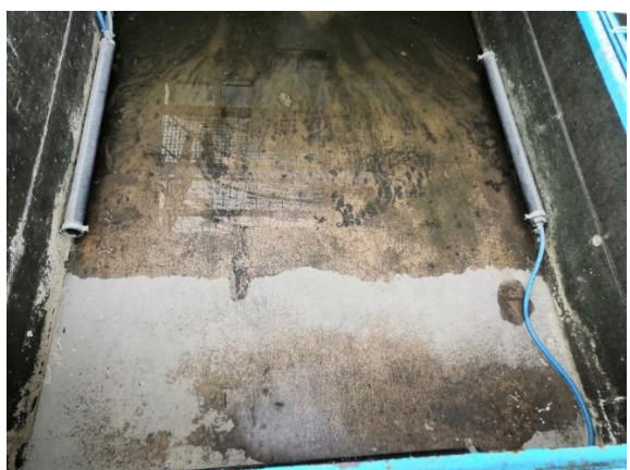
Obr. 4. Pohled na vypuštěnou manipulační nádrž a aerační trubice nového systému.
