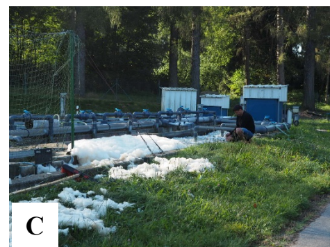
Obr. 2. Jednokomorový plovoucí (A), osmikomorový ponořený biofiltr (B) o celkovém objemu vody 550 m 3 a hluboký airlift (C) recirkulačního akvakulturního systému produkčního podniku BioFish s.r.o.
