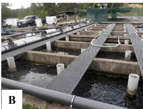
Obr. 2. Jednokomorový plovoucí (A), osmikomorový ponořený biofiltr (B) o celkovém objemu vody 550 m 3 a hluboký airlift (C) recirkulačního akvakulturního systému produkčního podniku BioFish s.r.o.
