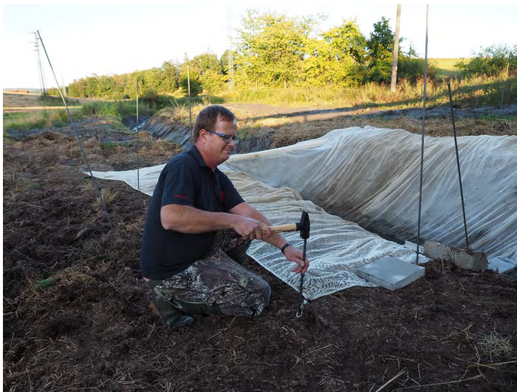
Obr. 24. Instalace podložní sítě do stoky pod hrází rybníku Sirotky dolní pro filtraci odtékající vody a zachycení unikající střevličky během spouštění a výlovu rybníku.
