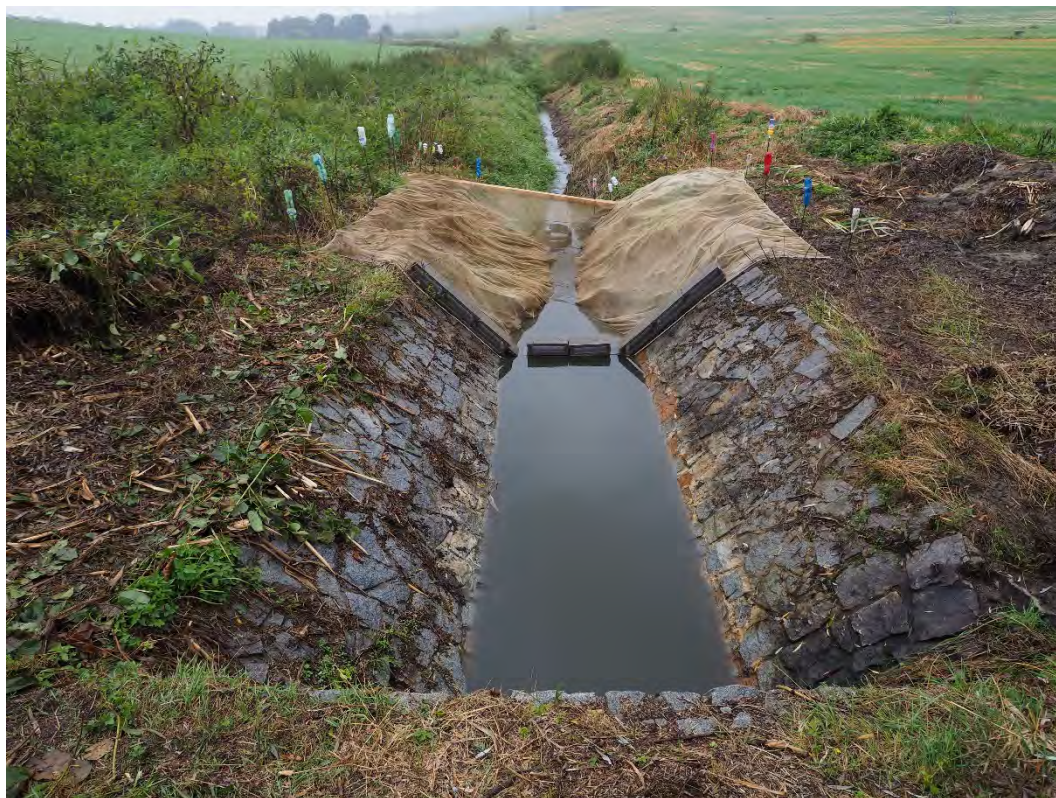
Obr. 25. Nainstalovaná podložní síť pod hrází rybníku Lusk pro zachycení unikající střepličky během spouštění a výlovu rybníku.
