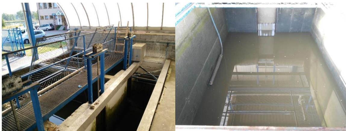
Obr. 5. Vlevo: pohled na výpustní zařízení manipulačních nádrží a slovovací kanál. Vpravo: pohled na vypuštěnou manipulační nádrž a aerační trubici starého systému.
