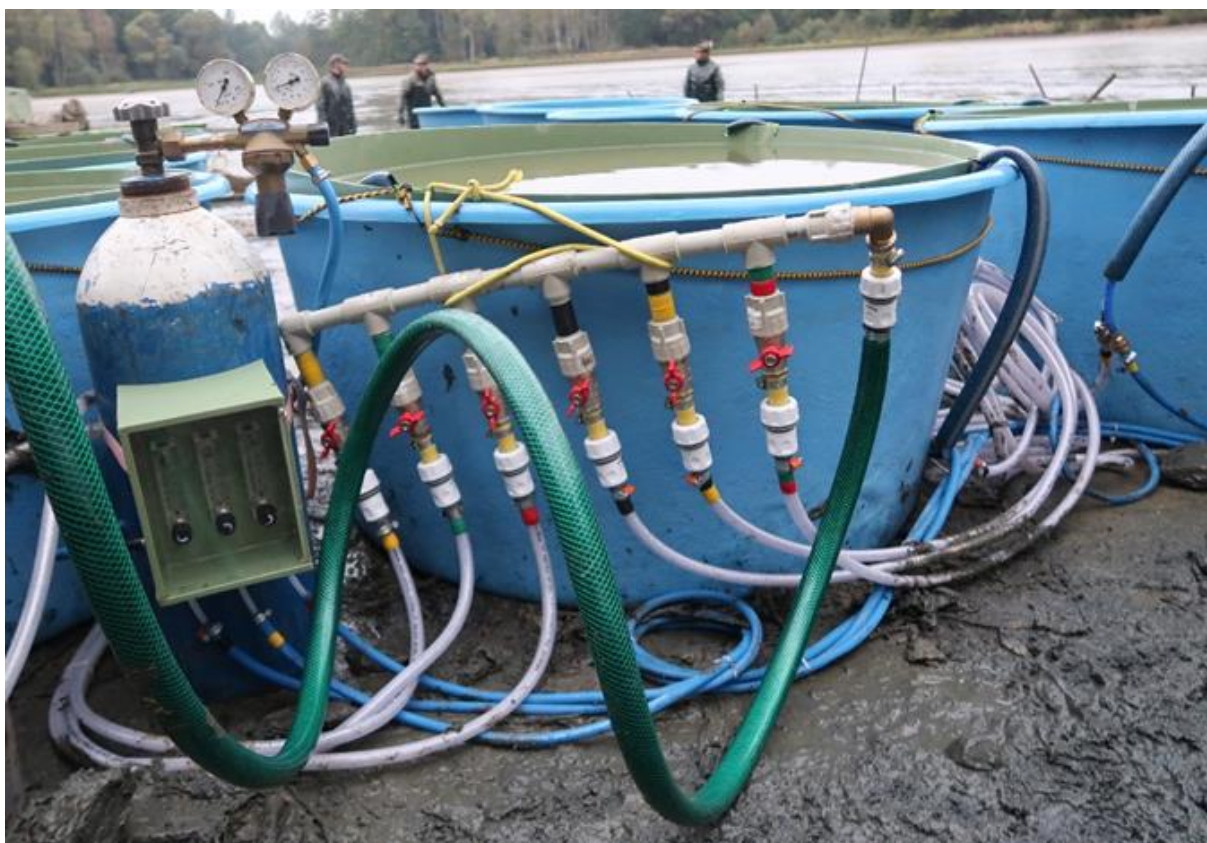
Obr. 4 Upravený centrální rozvod vzduchu (šedivé pastové trubky) a kyslíku (zelený box na kyslíkové lahvi) na rybníku Stará Komora (foto J. Regenda).
