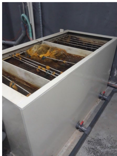
Obr. 11., 12. a 13. Filtr hrubých nečistot se 40 kartáči a 16 rašlovými pytli s biofiltračními elementy (vlevo), kombinovaný filtr Nexus 300 (uprostřed) a retenční nádrž chovné části s čerpadlem (vpravo).
