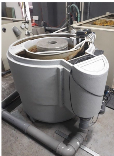
Obr. 11., 12. a 13. Filtr hrubých nečistot se 40 kartáči a 16 rašlovými pytli s biofiltračními elementy (vlevo), kombinovaný filtr Nexus 300 (uprostřed) a retenční nádrž chovné části s čerpadlem (vpravo).
