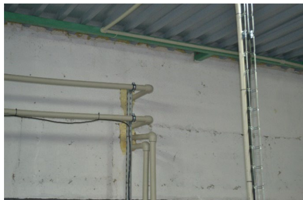
Obr. 25. a 26. Původní rozvody vody v trubkách PPR 50 x 6,9 s nevyhovujícím vnitřním průměrem snižující množství transportované vody.
