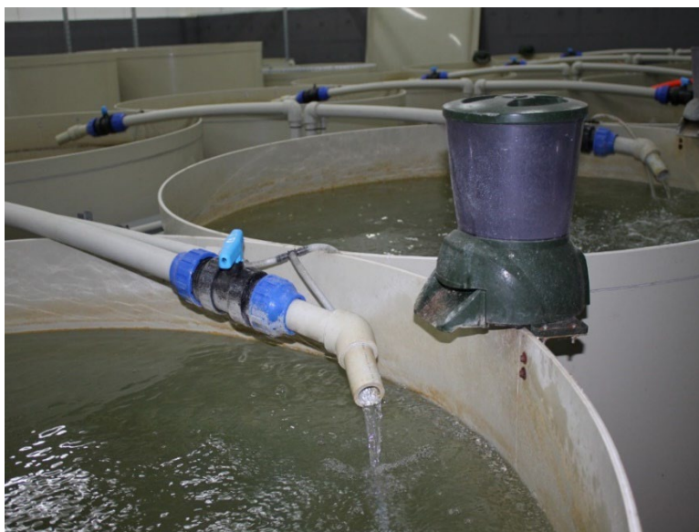
Obr. 16. a 17. Původní přítoky do chovných nádrží (vlevo) a původní rozvody vody (vpravo) vedené v trubkách PPR 50 mm x 6,9 mm do všech sedmi chovných nádrží.
