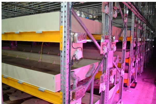
Obr. 14. a 15. Stojan s pěstebními nádržemi (vlevo) a retenční nádrž pěstební části s čerpadlem (vpravo).
