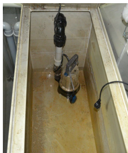
Obr. 11., 12. a 13. Filtr hrubých nečistot se 40 kartáči a 16 rašlovými pytli s biofiltračními elementy (vlevo), kombinovaný filtr Nexus 300 (uprostřed) a retenční nádrž chovné části s čerpadlem (vpravo).
