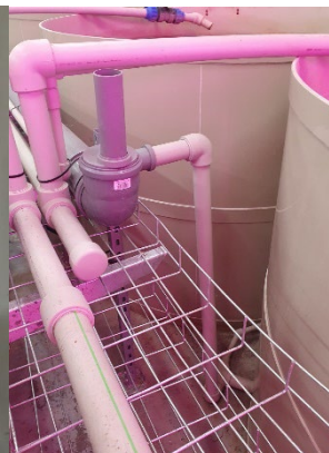
Obr. 18. a 19. Původní dno chovných nádrží (vlevo) a airlift pro vypuštění nádrže (vpravo).
