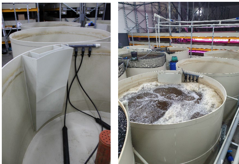
Obr. 35. a 36. Konstrukce mineralizační nádrže s přepadem (vlevo), mineralizace kalů (vpravo).
