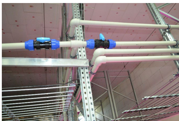
Obr. 25. a 26. Původní rozvody vody v trubkách PPR 50 x 6,9 s nevyhovujícím vnitřním průměrem snižující množství transportované vody.
